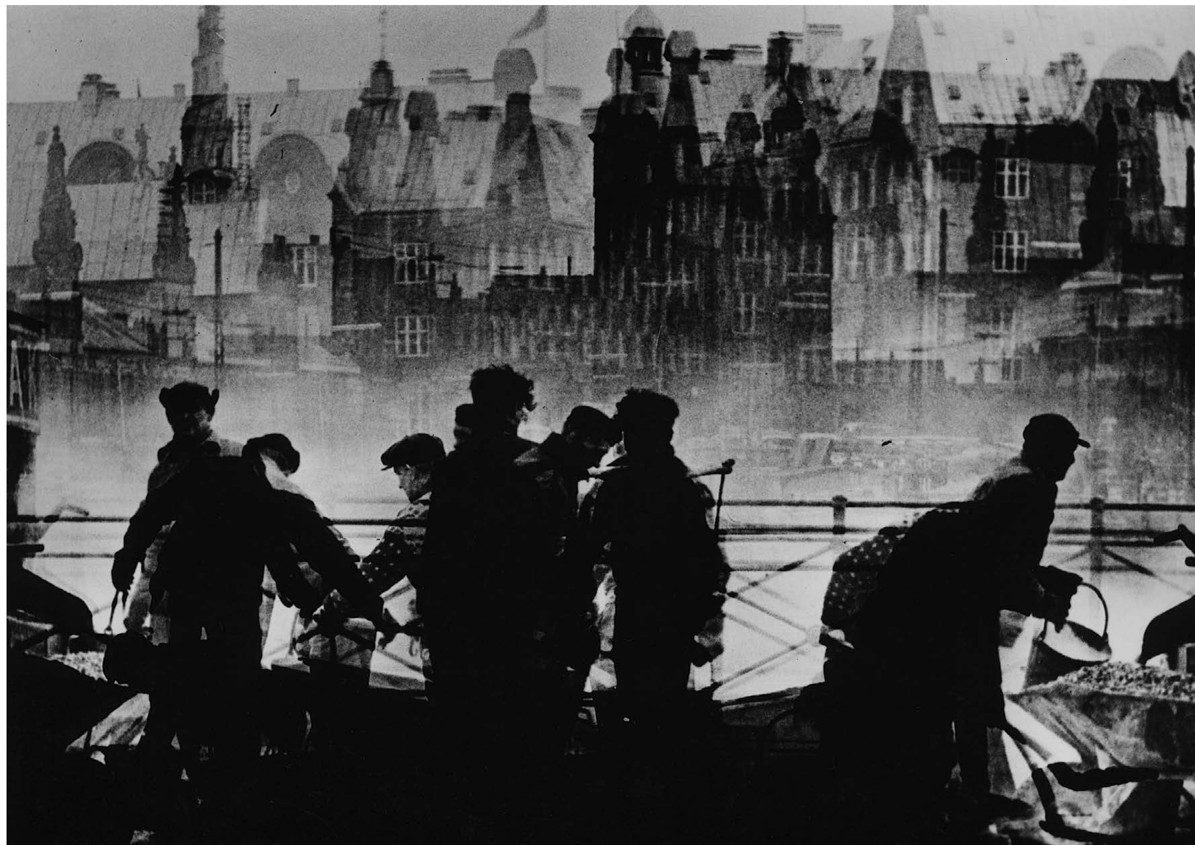
Tage Poulsen, Asfaltarbejdere , 1968
